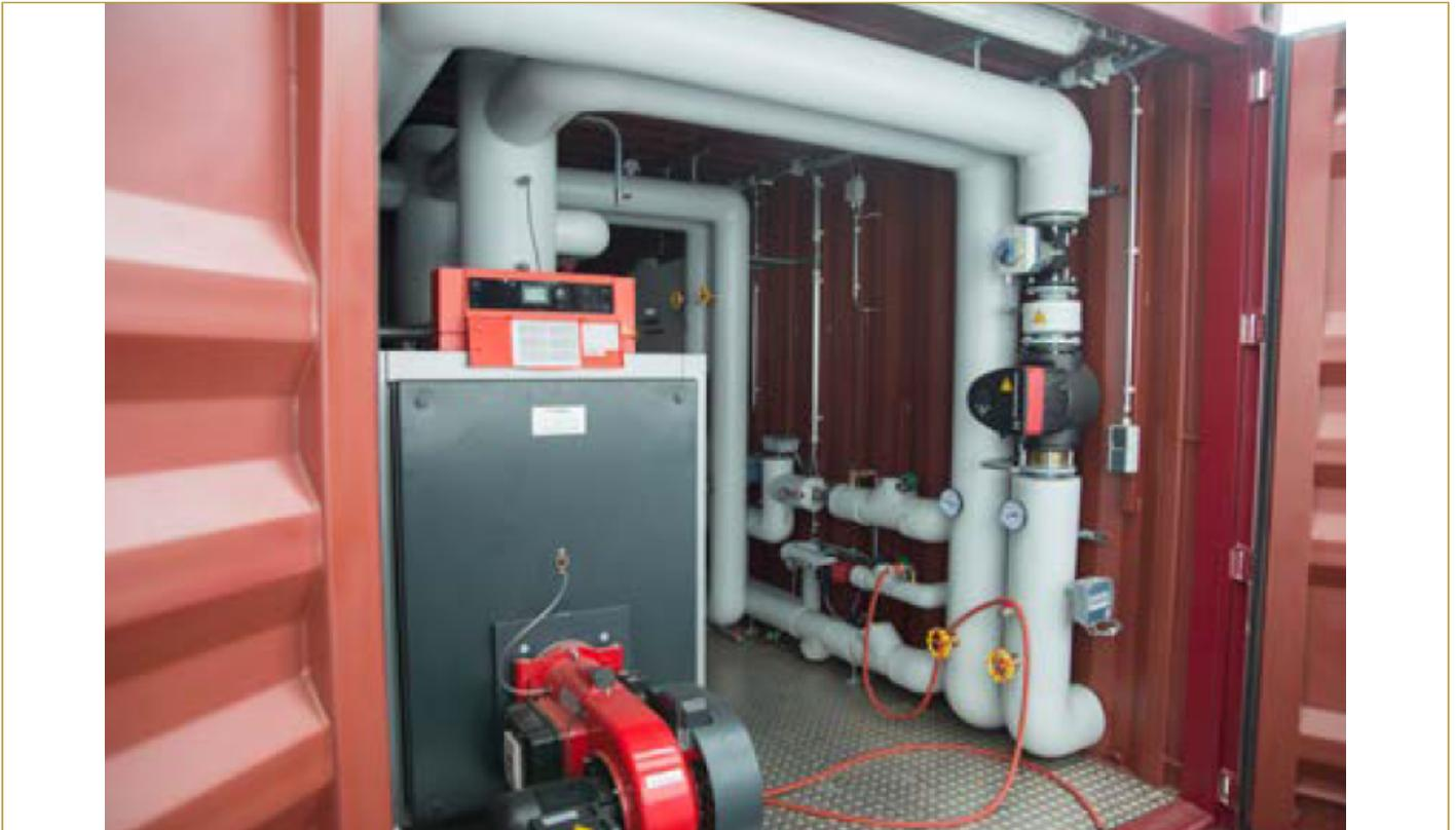
Mobiler Heizcontainer / Hotmobil mit insgesamt 550kW Heizleistung.
